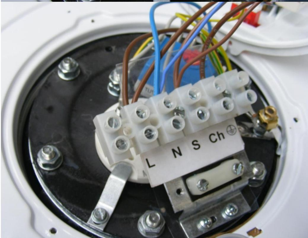
**Б.** Бойлер нагревается от ТЭНа, регулирование температуры с помощью терморегулятора бойлера.
