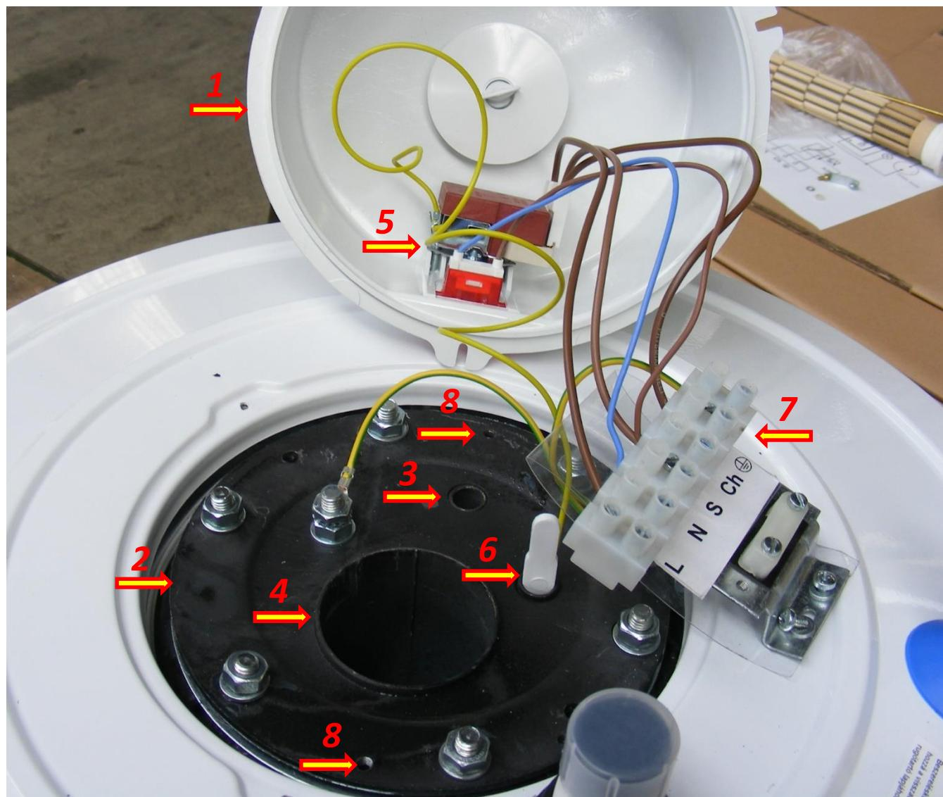
**2. Установить чувствительный элемент терморегулятора в гильзу (3), а ТЭН в колбу (4), см. схема выше.**
