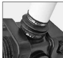
Рис. 9 Монтаж вентиляционного трубопровода
