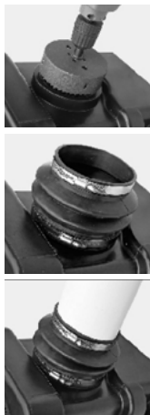
Рис. 8 Подсоединение вертикального подводящего трубопровода 110 мм (DN100)
